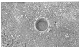
ピュアパイル工法普及振興会が推進するピュアパイル工法。「施工現場がきれい」「残土処理のコストを低減できる」といったことが支持を受け、採用実績を伸ばしている。
